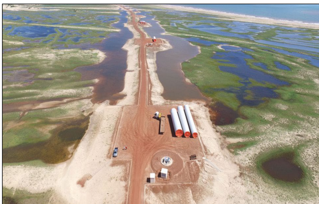
Figura 3 – Fotografia destacando a terraplanagem e uma compactação do solo por meio da instalação de um empreendimento no Delta 2.
